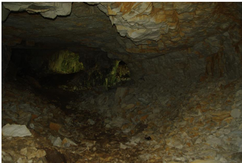
Destrukcja ścian w Sali z Piargami
