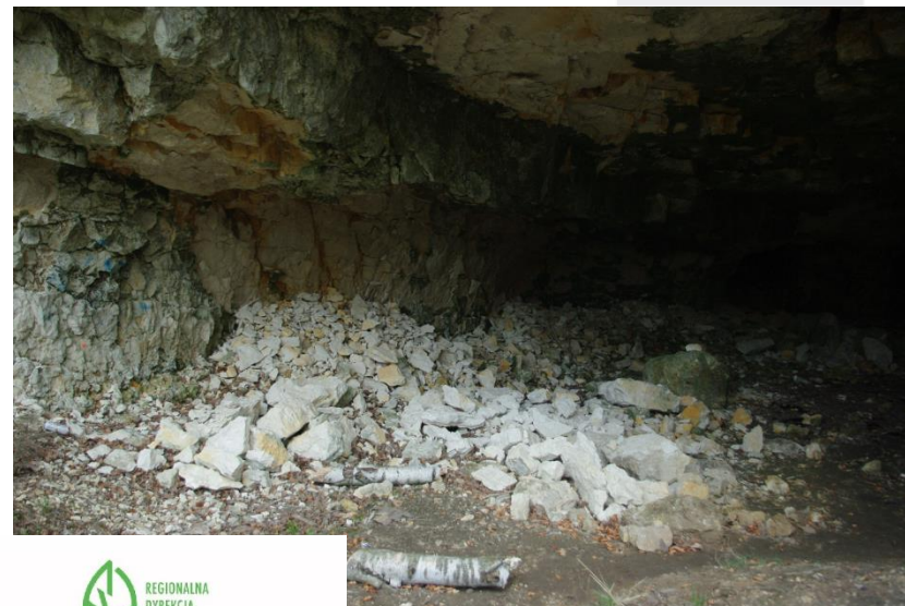
Destrukcja ścian i stropu w Sali Wejściowej
