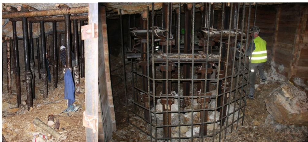
Fot. Od lewej: Tymczasowa obudowa podporowa (stojaki). Konstrukcja jednego z filarów
