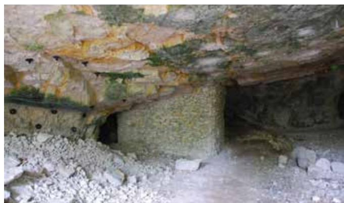
Rys. 4. Gotowy filar, źródło: opracowanie własne
