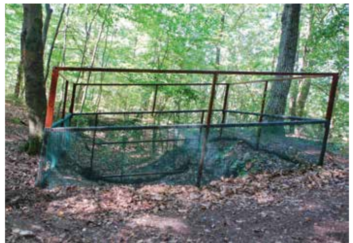
Rys. 7. Zabezpieczenie wlotu studni krasowej, źródło: opracowanie własne
