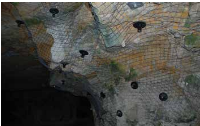
Rys. 6. Zabezpieczenie ociosów za pomocą siatki stalowej i kotew, źródło: opracowanie własne
