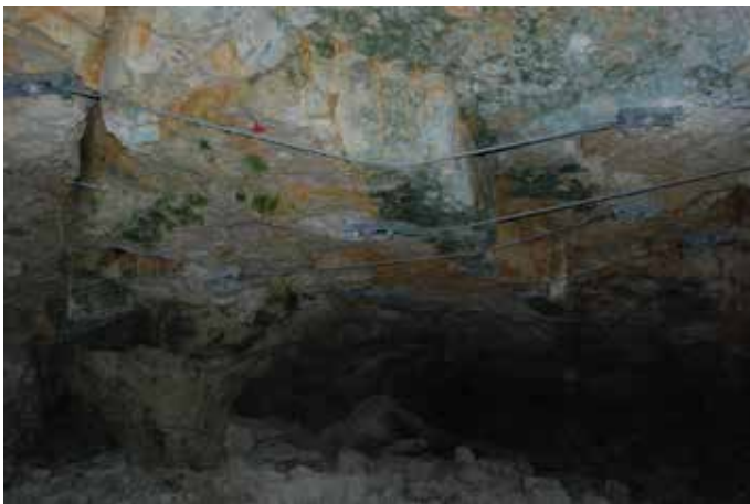
Rys. 5. Obudowa kotwowo-ciężnowa, źródło: opracowanie własne
