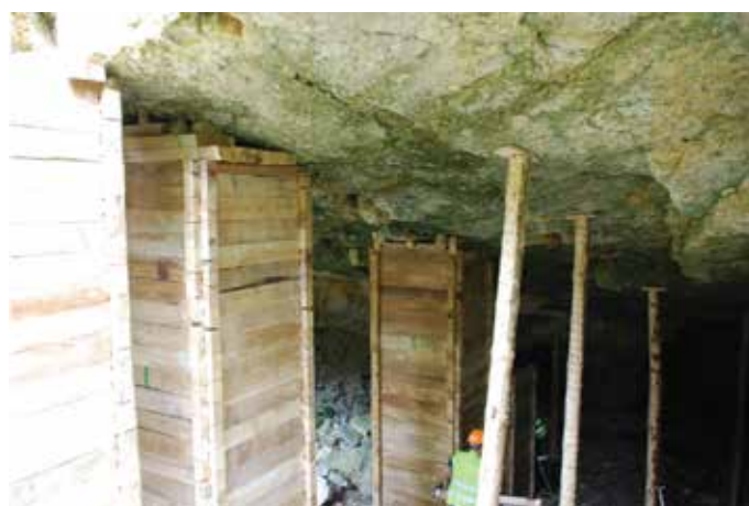
Rys. 3. Zabudowane kaszty, źródło: opracowanie własne
