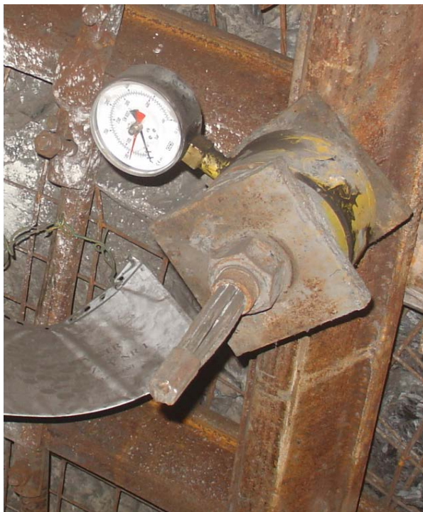
Fot.19.2. Dynamometr zabudowany na kotwi
