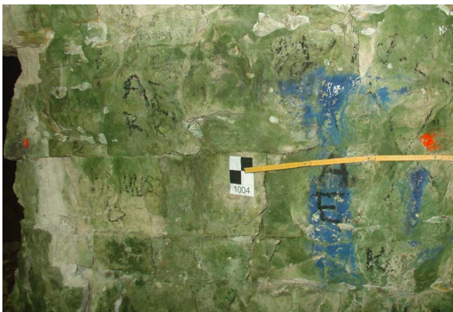
Fot.10.2. Punkt referencyjny 1004 naklejony na ścianie Małego Filara
