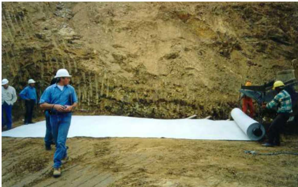
Fot.17.3. Układanie maty izolacyjnej rozwijanej z rolki (Mata, 2014)
